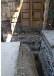
Szigeteléshez előkészítő munkaárok
